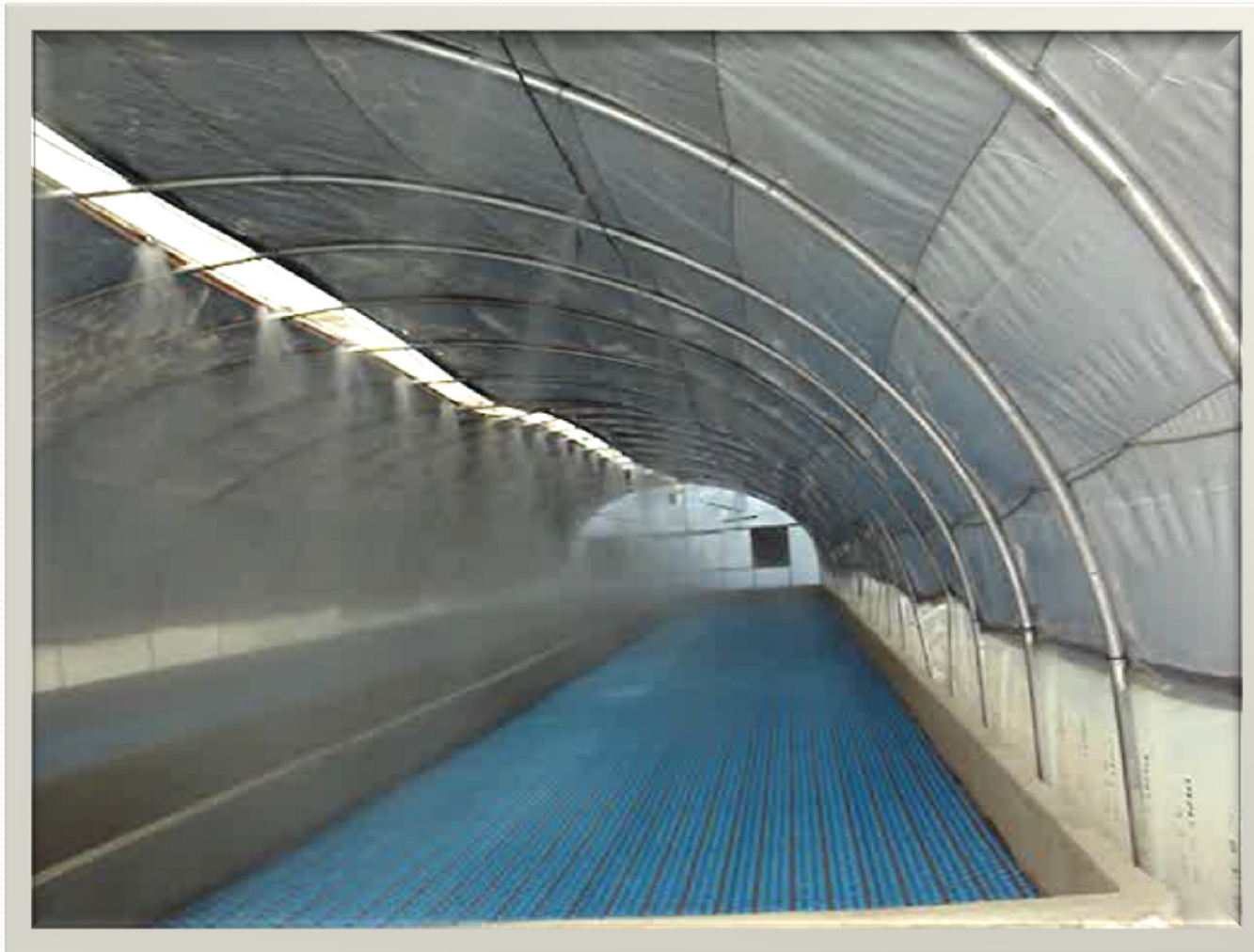
Serre en construction à Marrakech
